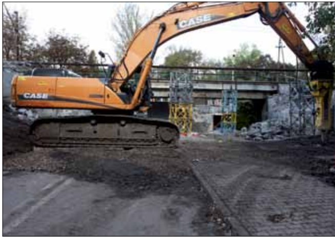
» Przebudowa mostu kolejowego nad ul. św. Jana.
