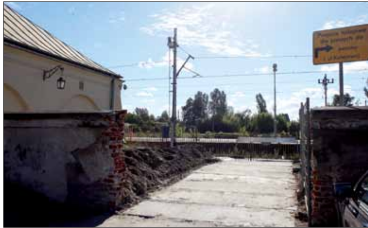
» Tymczasowe przejście na perony oraz z Pl. Piłsudskiego do ul. Kolejowej.
