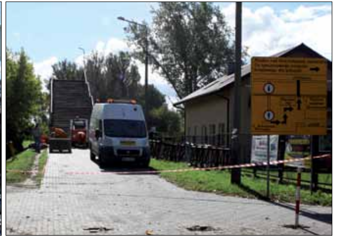
» Rozpoczęły się prace związane z likwidacją kładki.
