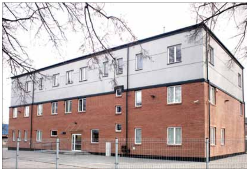
» Centrum Rehabilitacyjne Artkinezis, Filia w Żyrardowie, ul. Wiejska 19/21
