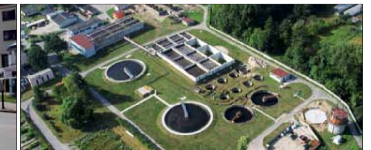
» Modernizacja infrastruktury wodno-kanalizacyjnej
