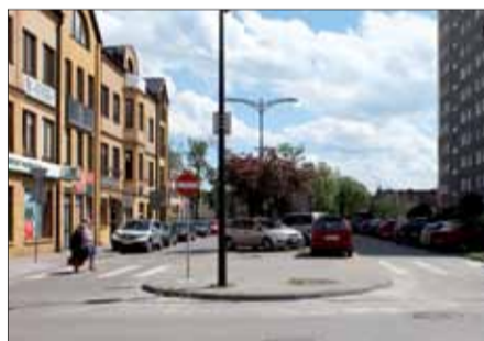
» Przebudowa ulic Łukasińskiego i P.O.W.
