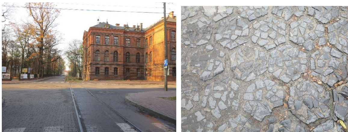
Historyczny, szynowy ciąg komunikacji przemysłowej. Historyczna nawierzchnia. Fot. A. Siwek
