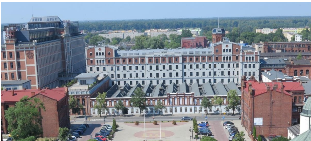
Stara przędzalnia i Stara tkalnia, fot. A. Siwek
