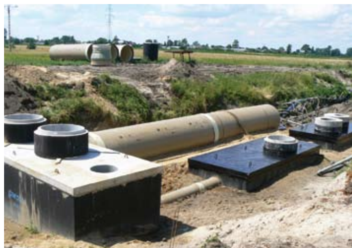
Budowa podczyszczalni ścieków w ul. Łąkowej
