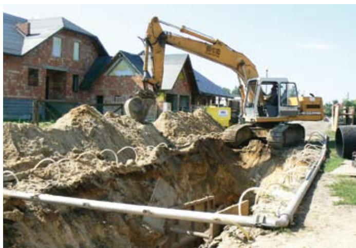
Budowa kolektora sanitarnego C w ul. Olszowej
