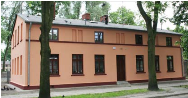
» Wyremontowana elewacja budynku przy ul. Limanowskiego
