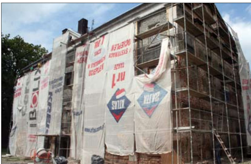
» W trakcie remontu jest również budynek przy ul. Dittricha 3
