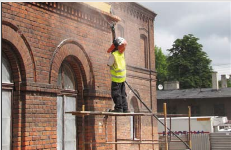
» Rozpoczęły się prace związane z czyszczeniem, uzupełnianiem i konserwacją ceglanej elewacji
