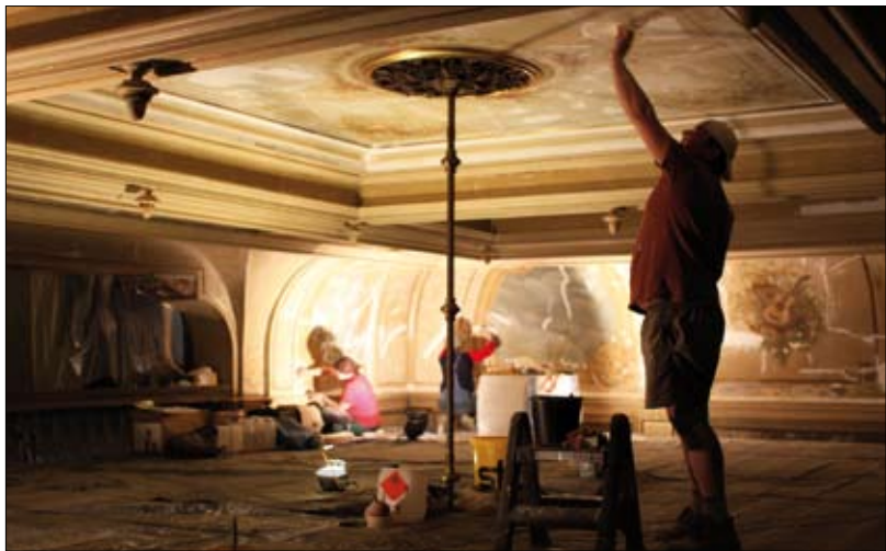
» Sala widowiskowo-teatralna w trakcie prac konserwatorskich
