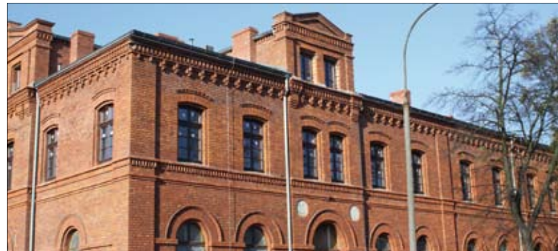
» Dobiegają końca prace związane z czyszczeniem, uzupełnianiem i konserwacją ceglanej elewacji oraz wymianą stolarki okiennej.
