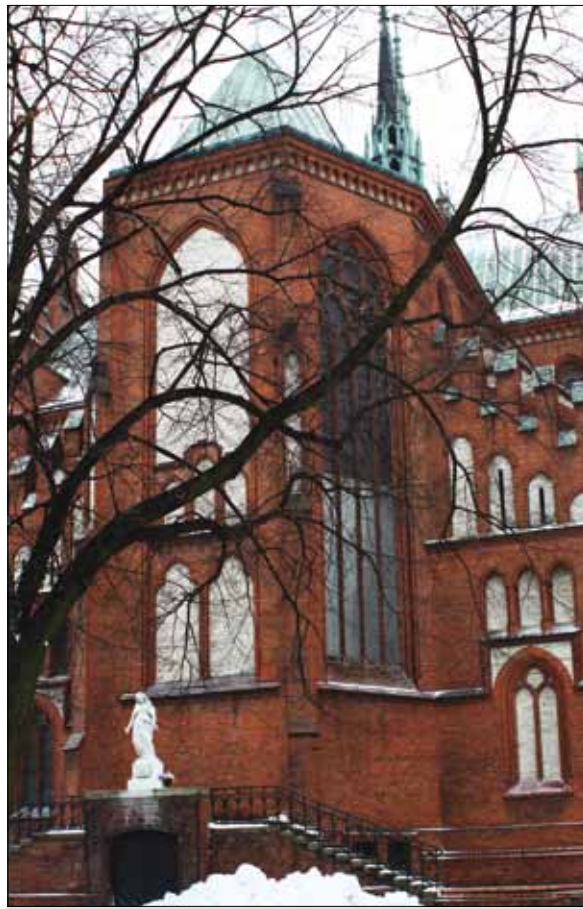
» Remont kościoła farnego zabezpieczy ceglana elewację przed dalszym niszczeniem.
