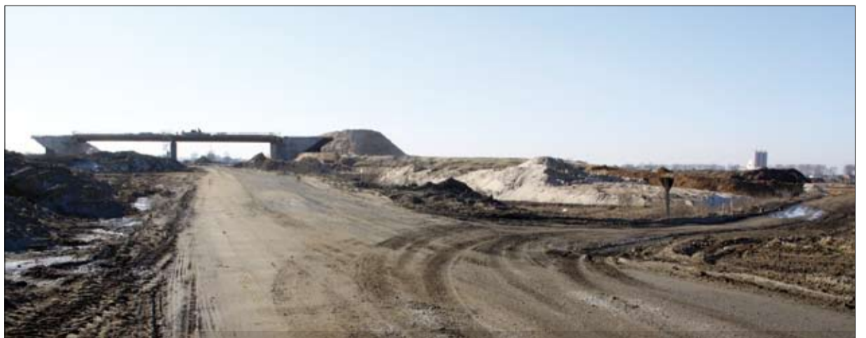
» Wiadukt nad autostradą A2 - Wiskitki.
