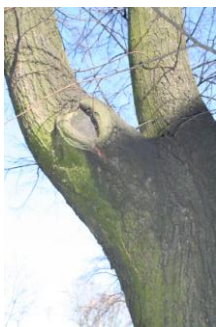
Równomierny kalus na jesionie po prawidłowo przeprowadzonym usunięciu gałęzi.
