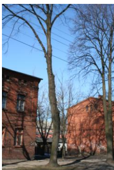
Kolizja z dachem i przewodami wymusiła mocne podniesienie korony.
