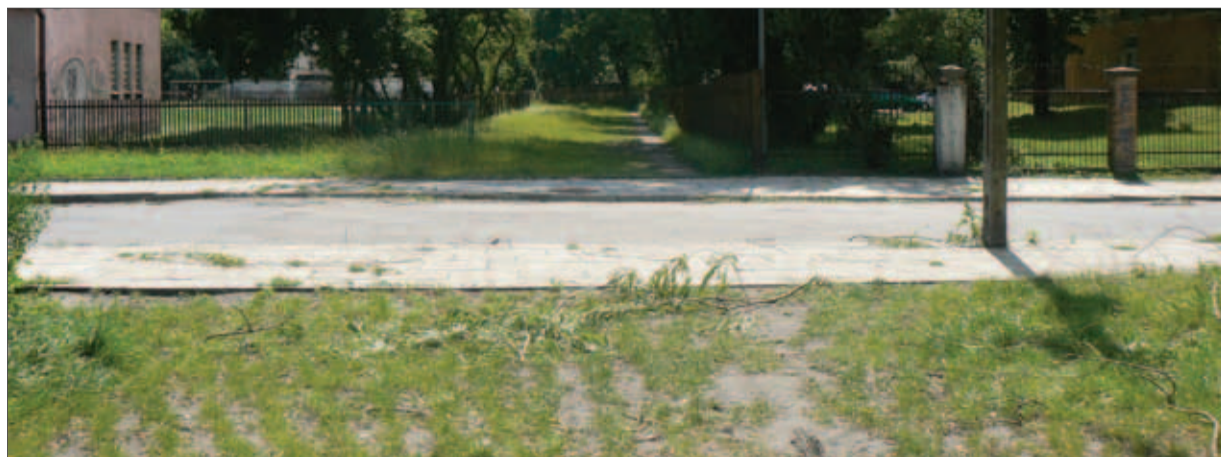
» Rów 51 po realizacji
