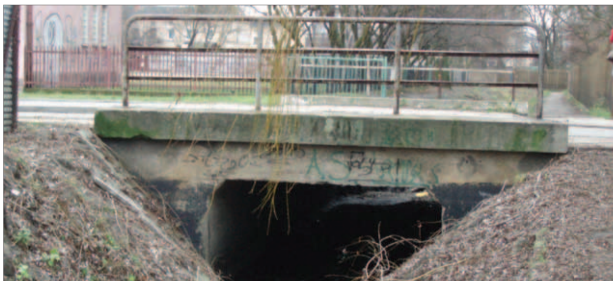
» Rów 51 przed realizacją
